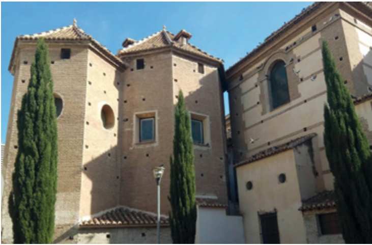
TRAS LA DESAMORTIZACIÓN LOS TERRENOS QUE OCUPABA EL CONVENTO DE SAN ANDRÉS O DEL CARMEN (MENOS LA IGLESIA QUE SE CONVIRTIÓ EN PARROQUIA) FUERON VENDIDOS A PARTICULARES. DESPUÉS DE DIVERSOS USOS Y DE AÑOS DE ABANDONO SE HAN ULTIMADO LAS OBRAS DE RESTAURACIÓN
