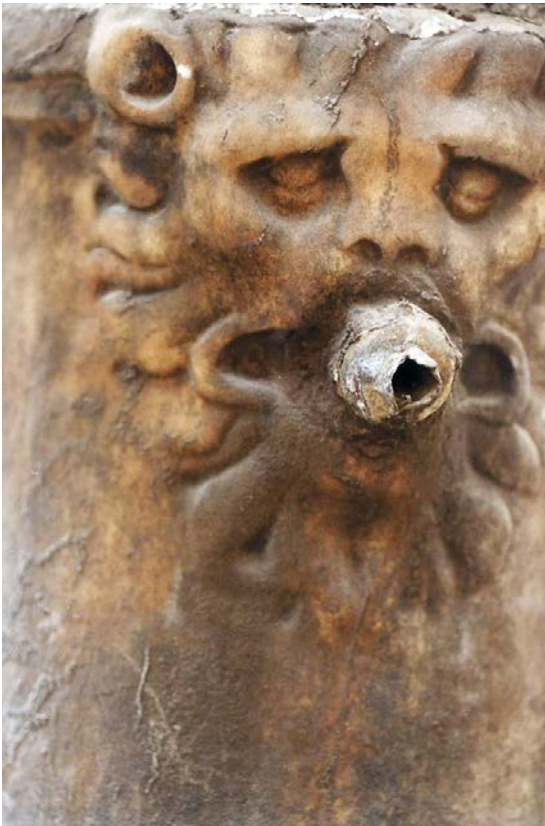
DETALLE DE UNO DE LOS MASCARONES ANTES DE LA RESTAURACIÓN DE 2003. CON ABUNDANTES DEPÓSITOS DE SUCIEDAD, PERO CON LA TALLA COMPLETA
