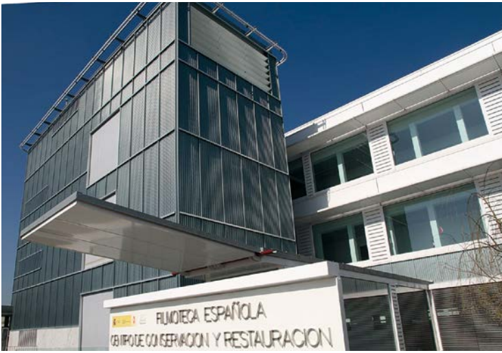
PORTADA DEL CENTRO DE CONSERVACIÓN Y RESTAURACIÓN. (CCR) CIUDAD DE LA IMAGEN
