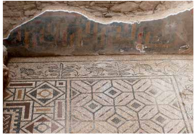
DETALLE DE UN ZÓCALO PINTADO EN PROCESO DE CONSOLIDACIÓN. FOTO: ESTRELLA ARCOS VON HAARTMAN
