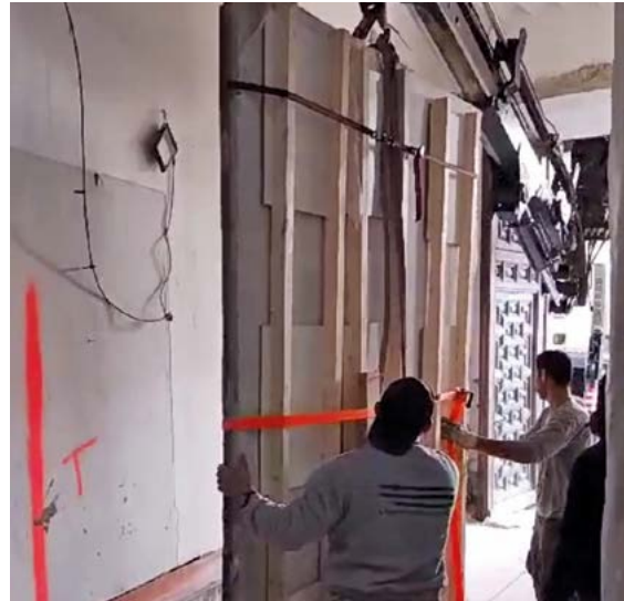
IZQUIERDA: FIG. 7. DETALLE DEL TRANSPORTE DE LA PIEZA IZQUIERDA. SE HA CONSTRUIDO UN CARRO METÁLICO CON RUEDAS A TAL EFECTO, SEGÚN EL ESPACIO DISPONIBLE PARA EL TRASLADO DE LAS PIEZAS. DERECHA: FIG. 8. DETALLE DEL ÚLTIMO TRAMO DEL TRASLADO, SALVANDO EL DESNIVEL ENTRE EL ZAGUÁN Y EL PATIO, PARA LO QUE FUE NECESARIO EL CONCURSO DE UNA GRÚA ARTICULADA.
