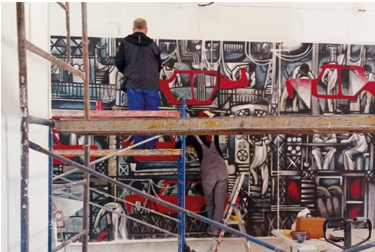
FIG. 10. VISTA DEL MURAL DURANTE EL PROCESO DE REINTEGRACIÓN CROMÁTICA DE LA CAPA PICTÓRICA.
