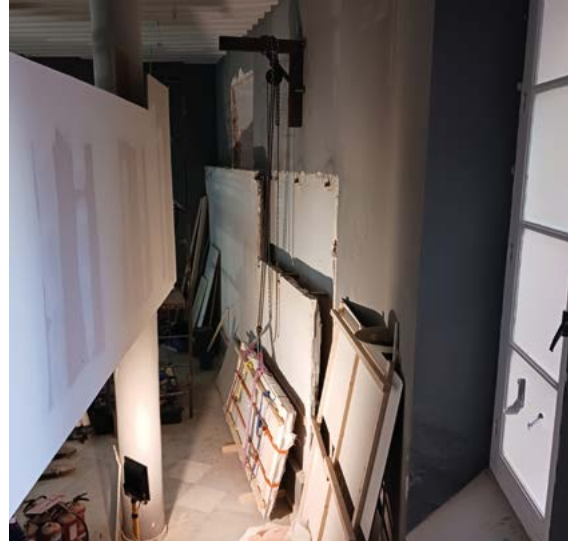
IZQUIERDA: FIG. 5. DETALLE DEL PROCESO DE PROTECCIÓN DE LA CAPA PICTÓRICA CON DOS CAPAS DE PAPEL Y UNA DE TELA, ADHERIDAS CON UN ENGRUDO DE ALMIDÓN. DERECHA: FIG. 6. DETALLE DEL MURAL TRAS EL DESMONTAJE DEL FRAGMENTO SUPERIOR DERECHO. SE APRECIA LA ESCUADRA MONTADA POR ENCIMA DE AQUEL Y LA PROTECCIÓN DEL FRAGMENTO, ASÍ COMO EL POLIPASTO DE CADENA UTILIZADO PARA SU DESMONTAJE.
