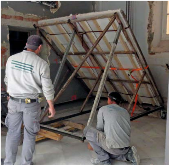
IZQUIERDA: FIG. 7. DETALLE DEL TRANSPORTE DE LA PIEZA IZQUIERDA. SE HA CONSTRUIDO UN CARRO METÁLICO CON RUEDAS A TAL EFECTO, SEGÚN EL ESPACIO DISPONIBLE PARA EL TRASLADO DE LAS PIEZAS. DERECHA: FIG. 8. DETALLE DEL ÚLTIMO TRAMO DEL TRASLADO, SALVANDO EL DESNIVEL ENTRE EL ZAGUÁN Y EL PATIO, PARA LO QUE FUE NECESARIO EL CONCURSO DE UNA GRÚA ARTICULADA.
