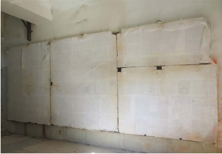
FIG. 9. VISTA DEL MURAL TRAS SU MONTAJE EN SU NUEVO SOPORTE, YA EN SU NUEVA UBICACIÓN. SE APRECIAN LOS CORTES REALIZADOS PARA SU DESMONTAJE Y LA PROTECCIÓN DE GASA SOBRE LA CAPA PICTÓRICA.
