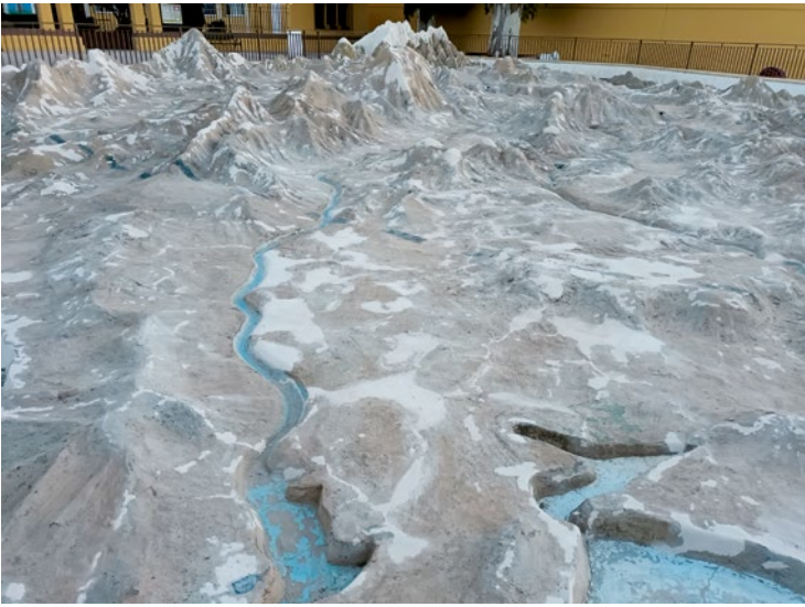
FIG. 6. ESTUCADO DE LAGUNAS Y SELLADO DE GRIETAS.
