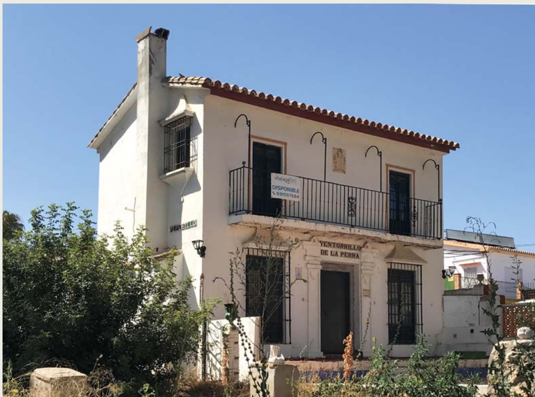
«VENTORRILLO DE LA PERRA». ESTADO DEL EXTERIOR
